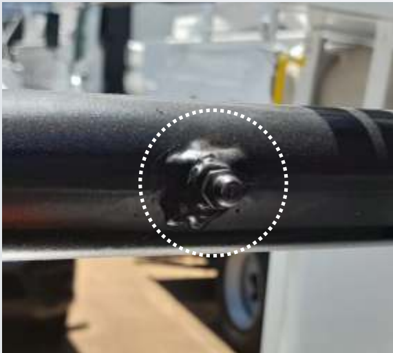
3 - Ponto de Lubrificação
