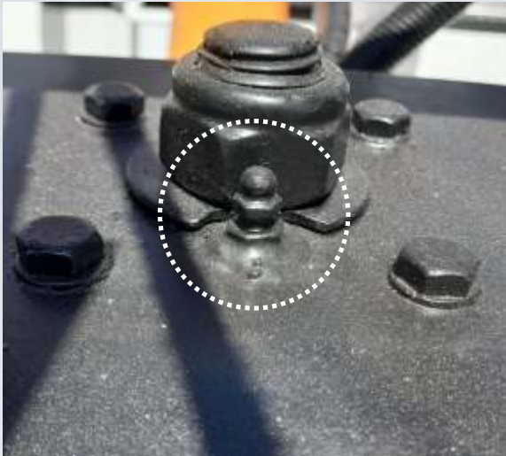
1- Ponto de Lubrificação
